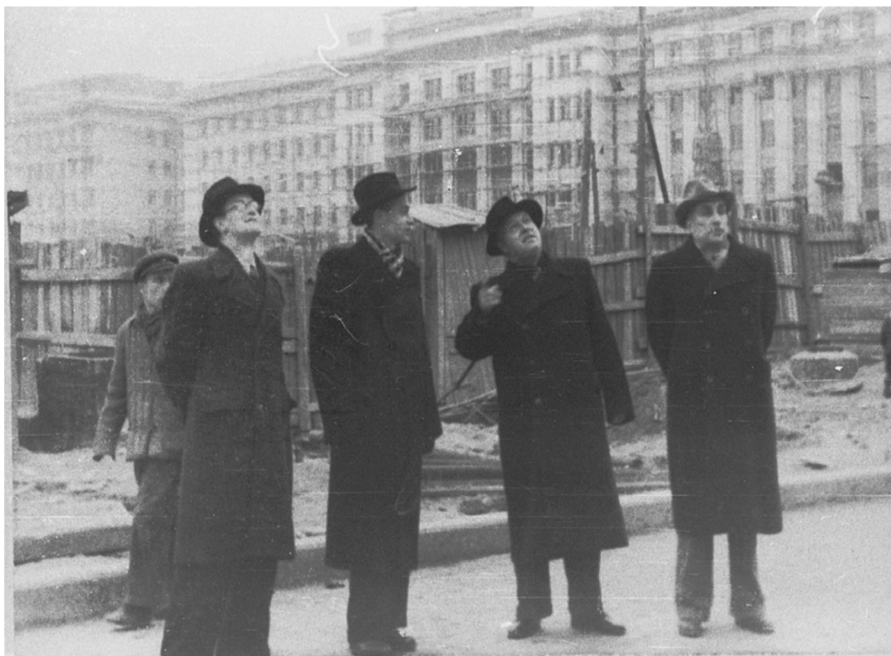
А.Н.Несмеянов на строительной площадке новых зданий МГУ (осень 1950 г.).
